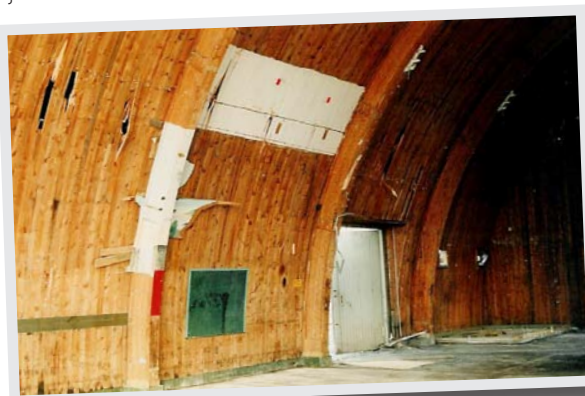
1 december 2002 revs pjäshallen, uppförd 1945. Rester av utbildningsanordningar i hallens nordvästra hörn.
