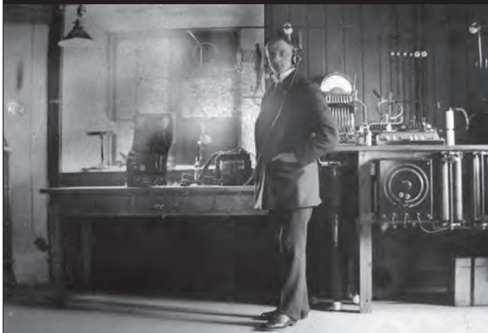
SAE Tingstade Gniststation i början på 1910-talet med AEG 8 kW gnistsändare enligt system "Tönende Funken" (Tingstade Hembygdsförenings arkiv).
