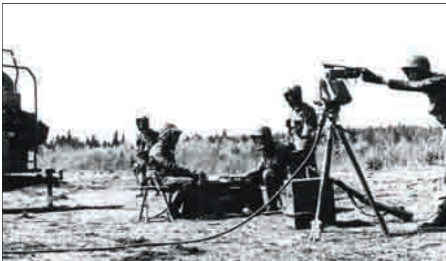
Centralsikte m/48 EF med bemanning. Vid dataomvandlaren sitter sambandskarl spaningsradar och sambandskarl pluton. Målobservatören vid målangivaren t.h. Stående eldledaren och antagligen plutonchefen.
